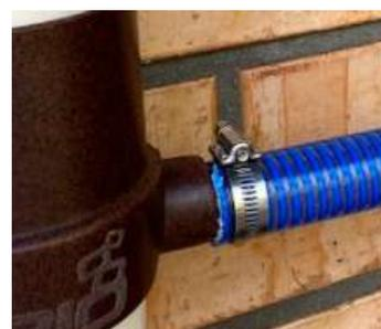
As cisternas vem acompanhadas por um filtro especial, que deve ser instalado no tubo de queda da calha. Este filtro separa folhas e partículas finas, evitando que as mesmas entrem na cisterna.
